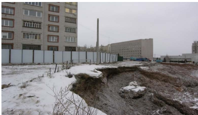
Рис. 1. Активный оползень на склоне котлована и разрывная трещина возле жилого дома
