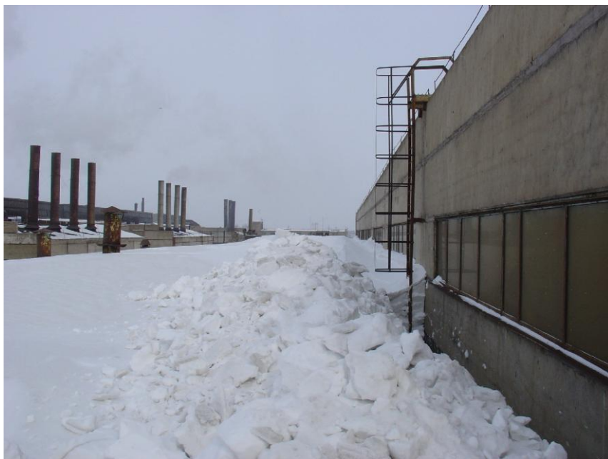
Фото 3. Снеговая нагрузка на покрытие в начале апреля 2005 года
