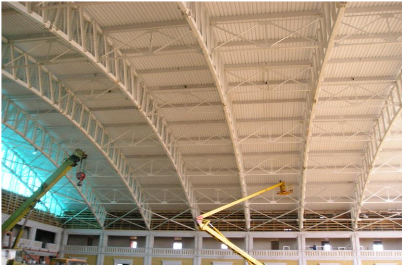
Рис. 2. Арки сквозного сечения пролётом 50 м.
