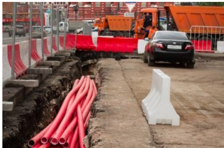
КАБЕЛЬНАЯ КАНАЛИЗАЦИЯ ВМЕСТО ВОЗДУШНЫХ ЛЭП
