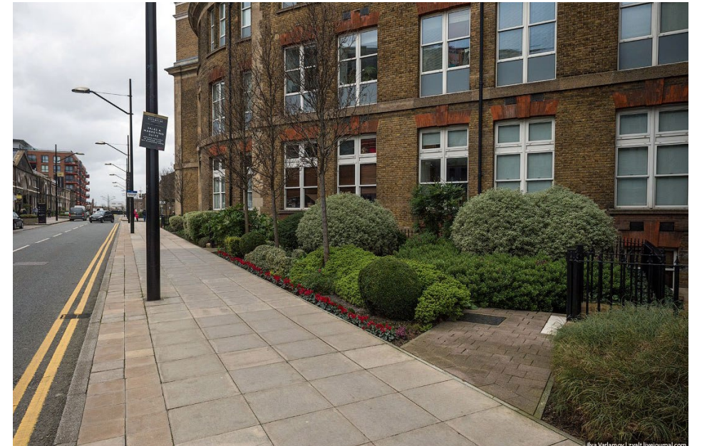
ТРОТУАР/ДОРОГА ВЫШЕ ГАЗОНА И ОТСУТСТВИЕ ОТКРЫТОГО ГРУНТА
