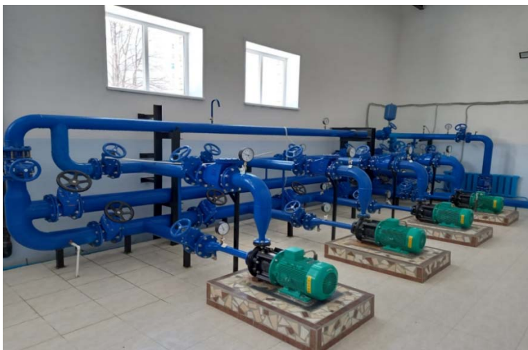
Рисунок 2 – Реконструкция насосного оборудования в машинном зале ЦТП №1
