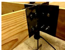
Рис. 1 – Узел крепления элементов СПБ
