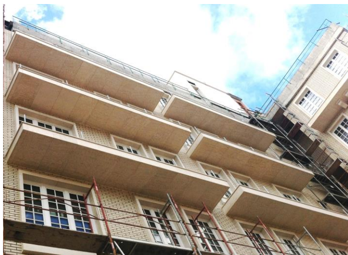
Рис. 14. Камни подшивок на балконах имеют размеры 1200х800мм и закрепляются на штифтах вдоль их швов.
