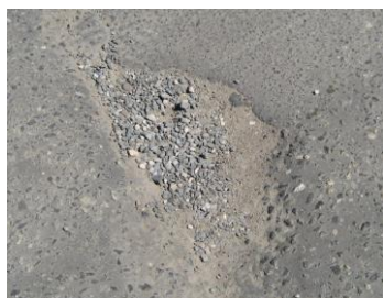
Рис. 4. Выбоина, заполненная гранитным щебнем
