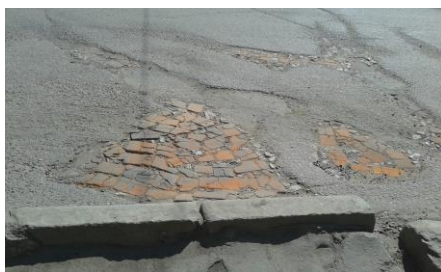
Рис. 9. Выбоина, заполненная керамическим полнотелым кирпичом спустя два месяца
