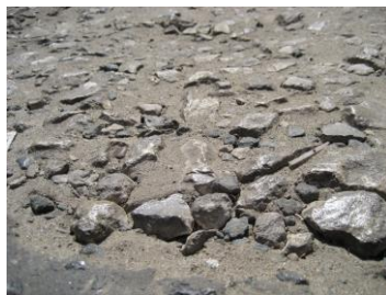
Рис. 7. Выбоина, заполненная малопрочным известняковым щебнем, с эффектом заклинки (приближенное фото)
