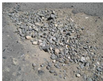
Рис. 5. Выбоина, заполненная гранитным щебнем, щебень не консолидировался (приближенное фото)
