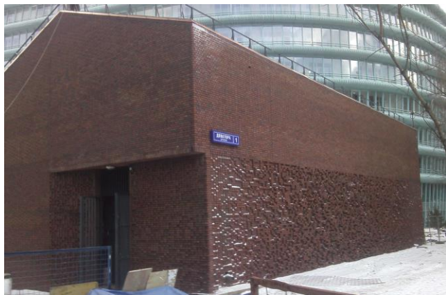
Рис. 5. Тяговая подстанция для Московского метро. Облицовка клинкерным кирпичом на НФС «FASPROF». Г. Москва, Доватора ул., д.1.
