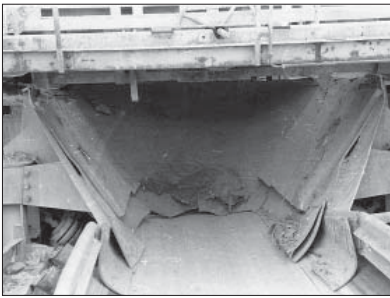
Рис. 1. Установка резиновых уплотнителей в приемном бункере ленточного конвейера
