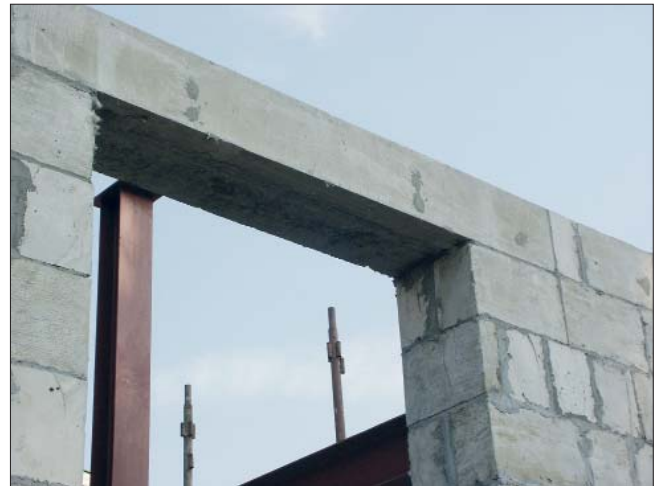
Рис. 2. Фибропеножелезобетонная перемычка на объекте цех фасовки медикаментов
