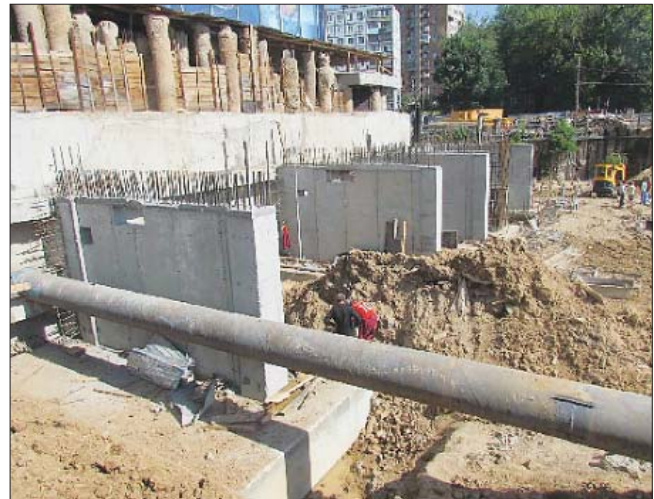
Рис. 2. Фрагменты выполненных контрфорсов
